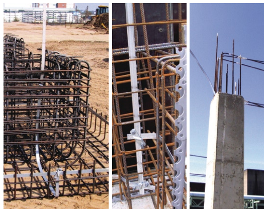
Токоотводы внутри железобетонных колонн
