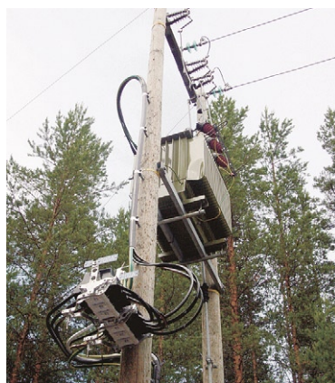
Фото 1. Мачтовая трансформаторная подстанция с мачтовыми рубильниками для низковольтных отходящих фидеров 0,4 кВ
