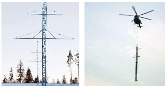
• Рис. 2. Узкобазовые быстромонтируемые опоры конструкции ЭЛСИ
