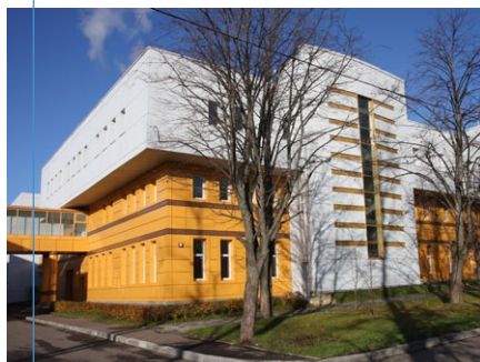
Новый цех по производству терминалов РЗА
